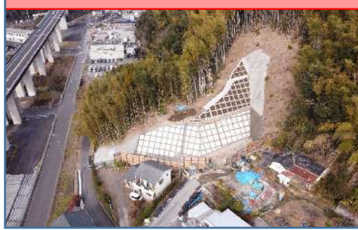
急傾斜地崩壊対策事業(小野町1地区)
