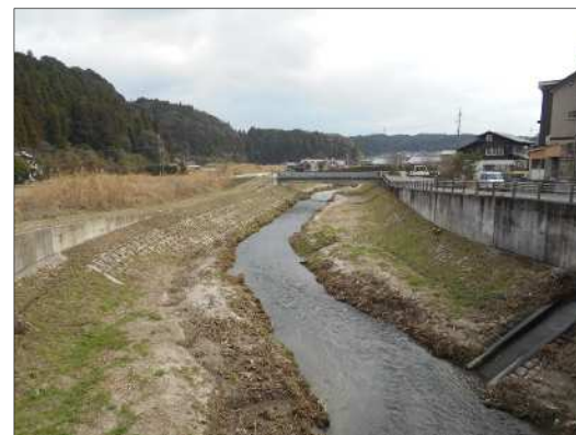
■整備状況（河川改修後）
