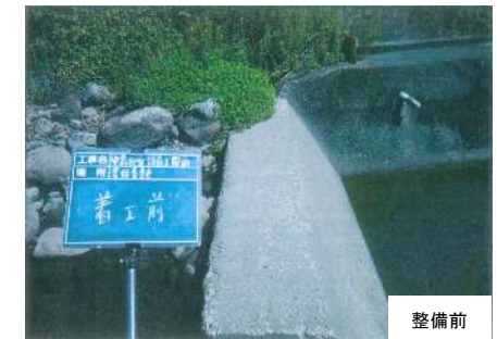
【取水堰の改良】
