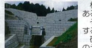
湯穴第1谷川砂防えん堤
