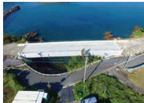
▲新たに架設した平尾地区橋梁
