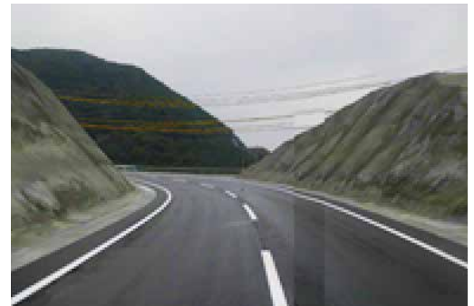
▲拡幅して2車線化した道路
