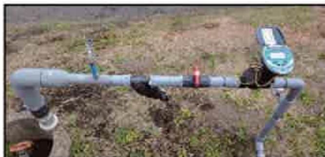
写真2 電磁弁を組み込んだ立ち上がり
