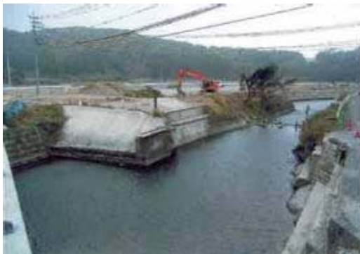
着工前：総合流域防災(河川)工事(湯田川)
