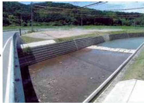
完成：総合流域防災(河川)工事(湯田川)
