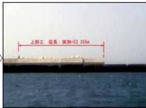
完成（川内港防波堤（西）改良）
