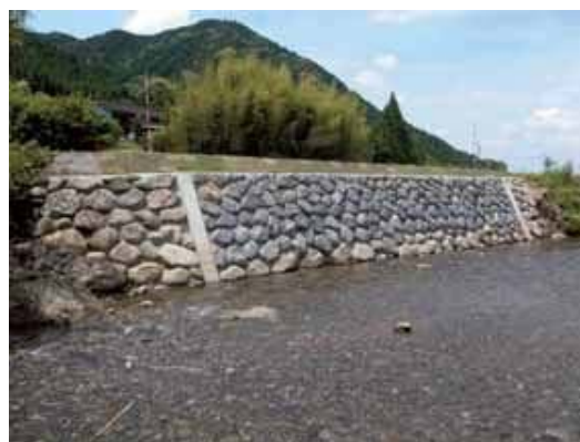
景観に配慮した河川護岸(南川)(さつま町)
