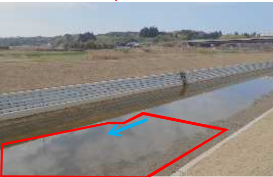
【施工後】折口川
