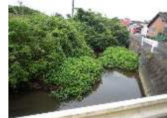
普通河川鶴見川支線河道掘削
