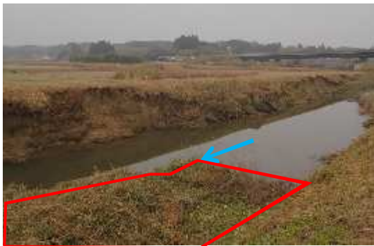
【施工前】折口川
