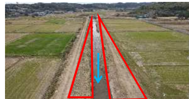
【施工後】折口川
