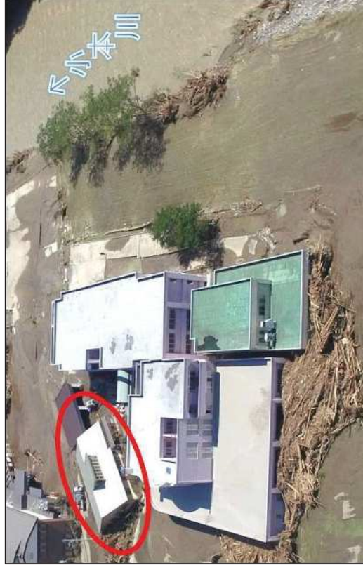
平成28年台風10号により、岩手県の要配慮者利用施設では利用者9名の全員が死亡。
