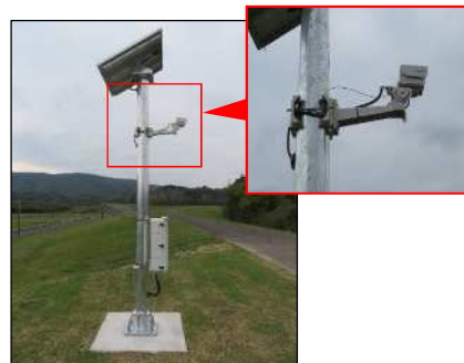
簡易型河川監視カメラ
