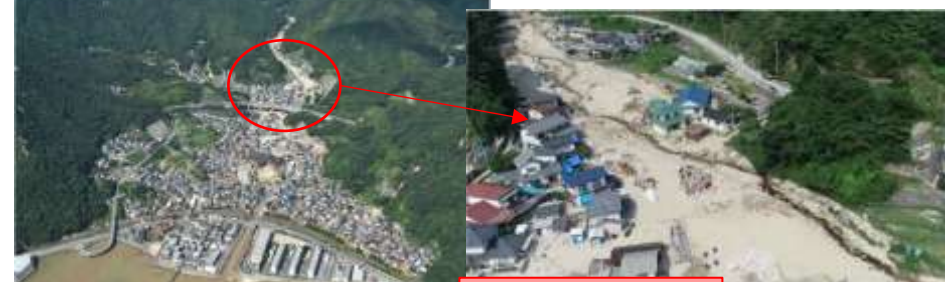
土砂・洪水氾濫の発生状況
