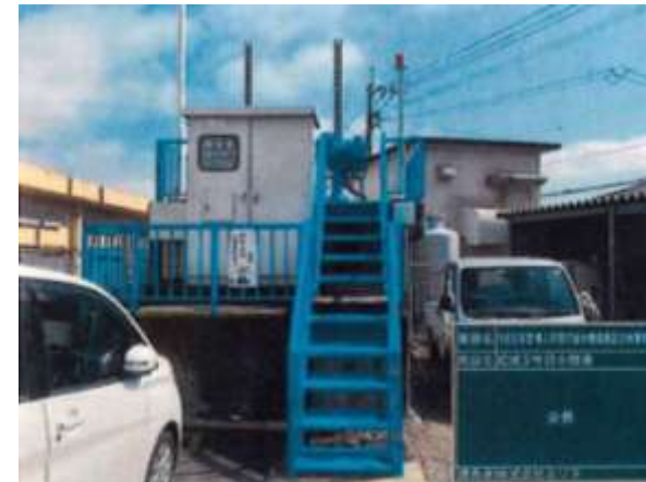
【排水機場等点検・維持管理】
