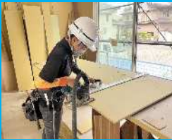
←内装ボード加工中
