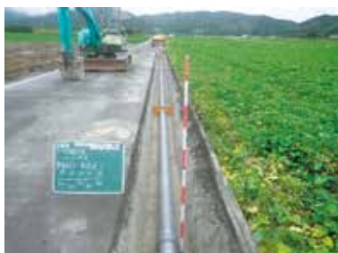
管水路埋設工事
