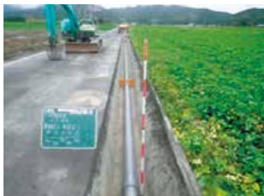
管水路埋設工事
