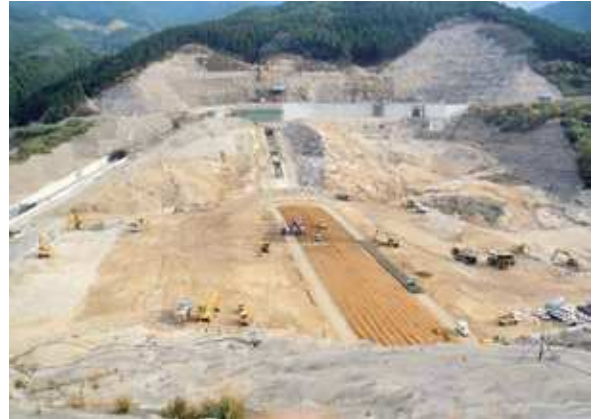
荒瀬ダムの工事状況
