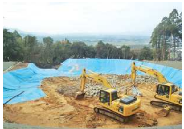
愛宕山第2ファームポンドの敷地工事の様子
