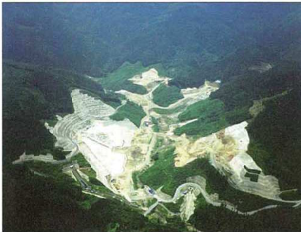
荒瀬ダム施工状況
