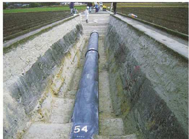
パイプライン埋設状況
