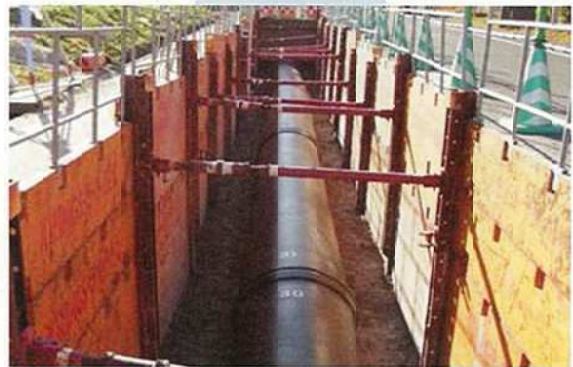
パイプライン埋設状況
