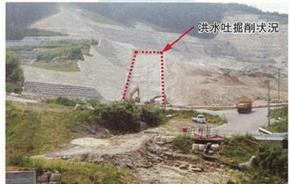
荒瀬ダム施工状況
