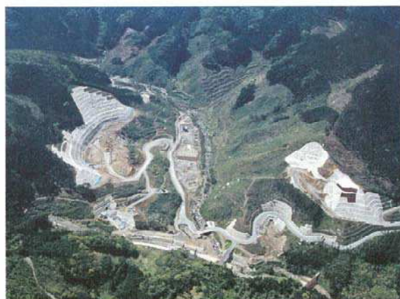
工事が進む荒瀬ダム (平成 18 年 4 月撮影)
