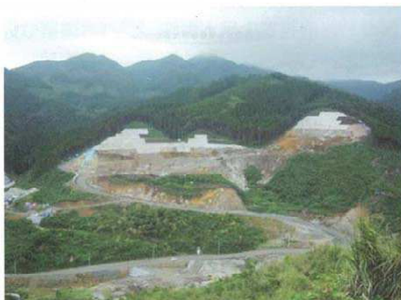
掘削が進む荒瀬ダム
