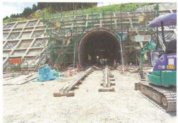
転流用の右岸仮排水路トンネル（平面図中①）
