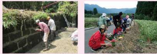
水路の簡易な補修
