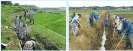
水路の泥上げ・草刈り
