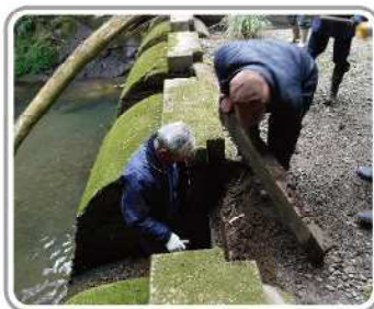
【施設の機能診断】
