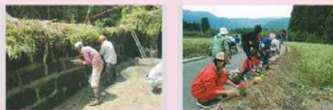
水路の簡易な補修
