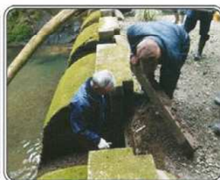
【施設の機能診断】
