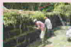
水路の健全な維持
