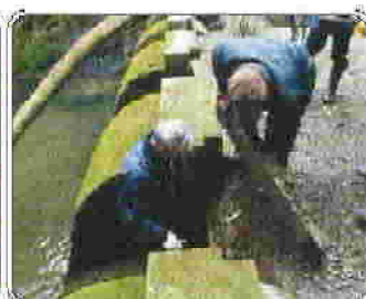
【施設の機能診断】
