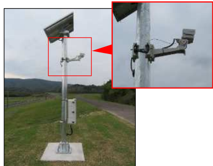
簡易型河川監視カメラ
