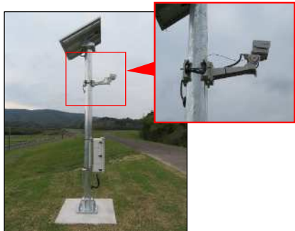
簡易型河川監視カメラ
