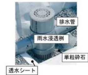
雨水浸透樹の設置事例
