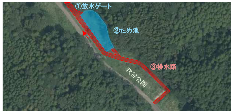
【湧水による排水路、ため池への流入】
