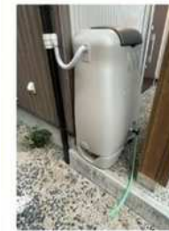
雨水貯留タンクの設置事例(250ℓ)
