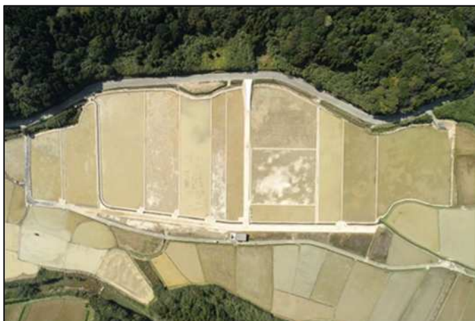
県営農地環境整備事業 河内浦地区 水田ほ場整備（南種子町 河内地内）
