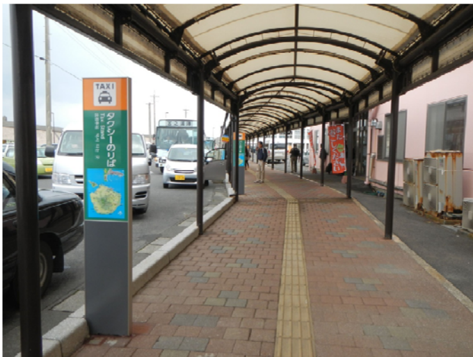
宮之浦港，安房港，屋久島空港に案内標識を設置（写真は宮之浦港）
