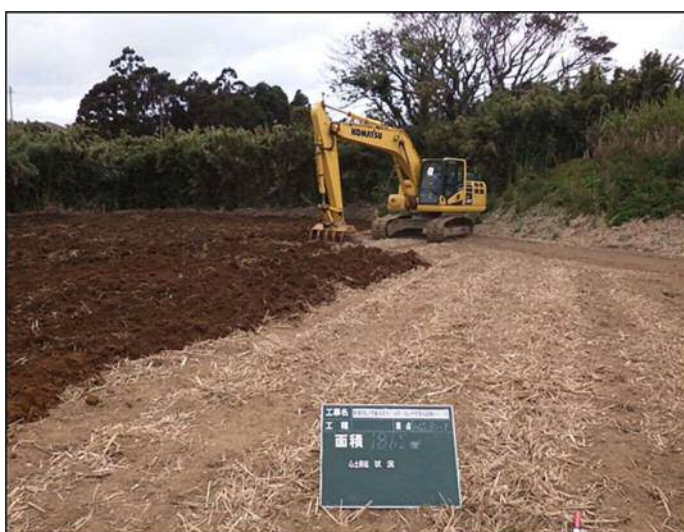
畑地帯総合整備事業（担い手支援型）野間西部地区 土層改良（中種子町 野間地内）
