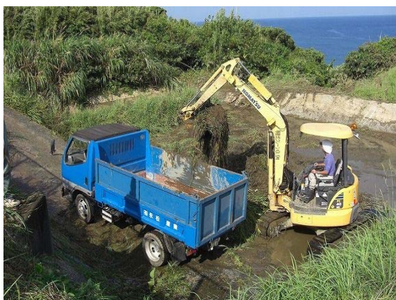
沈砂池の土砂排除作業
