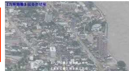
⑪球磨川における浸水被害状況 (熊本県人吉市)
