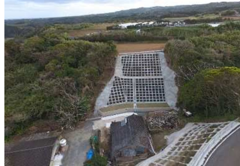
治山施設の整備(山腹工)
