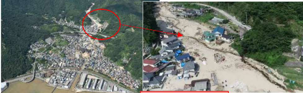
土砂・洪水氾濫の発生状況
