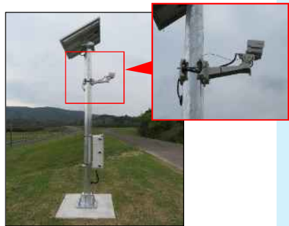
簡易型河川監視カメラ
