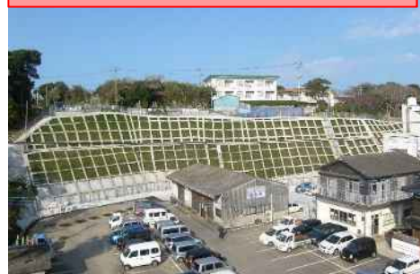
急傾斜地崩壊対策事業(西之表市:西町地区)
