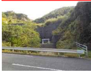
急傾斜地崩壊対策事業 (西之表市:西町地区)
