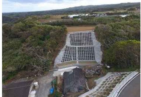
治山施設の整備(山腹工)
