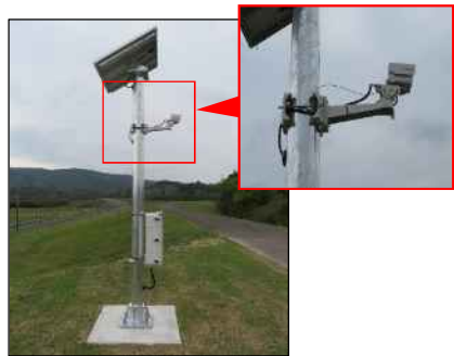
簡易型河川監視カメラ
