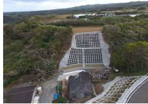
治山施設の整備(山腹工)
