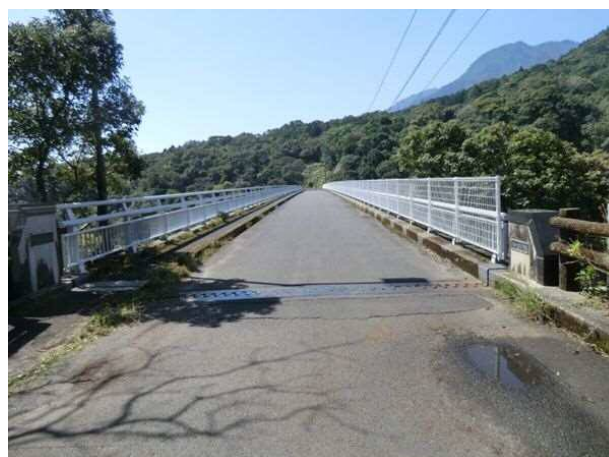
松峰大橋全景
