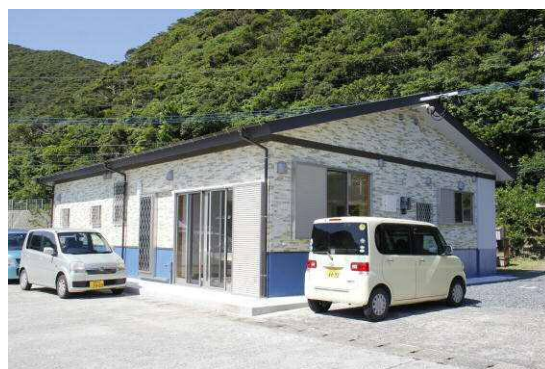
水産加工施設 完成 (大和村・令和元年5月)
