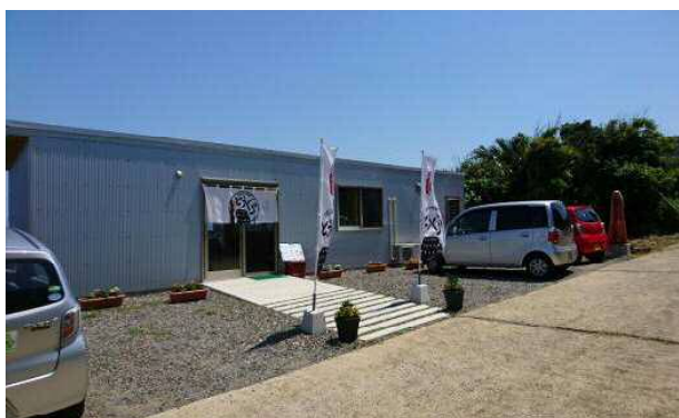
ジビエカフェとうぐら 完成 (徳之島町・平成31年4月)
