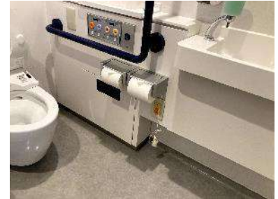
●空港入口横に設置された航空会社の車いすトイレの確認状況。設置位置が低すぎる非常用ブザーのボタン。
