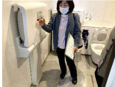
●空港入口横に設置された航空会社の車いすトイレの確認状況。設置位置が低すぎる非常用ブザーのボタン。
