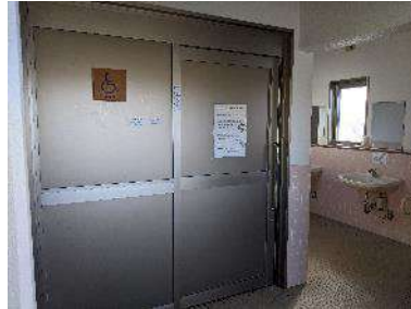
●多目的トイレはスロープや入口の幅、広さを確認した。トイレトイレットペーパーホルダーの位置は後ろ過ぎのようだ。
