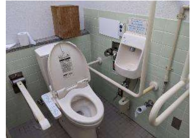
●多目的トイレはスロープや入口の幅、広さを確認した。トイレトイレットペーパーホルダーの位置は後ろ過ぎのようだ。
