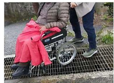
グレーチングも難所になる
