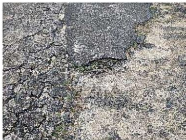
コンクリート舗装と土舗装や砂利敷きの境目の凹凸は衝撃が大きい
