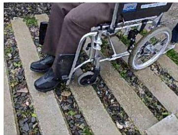
コンクリート舗装と土舗装や砂利敷きの境目の凹凸は衝撃が大きい
