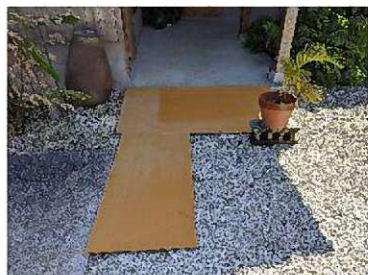
約3cmの段差はベニヤ板で解消
