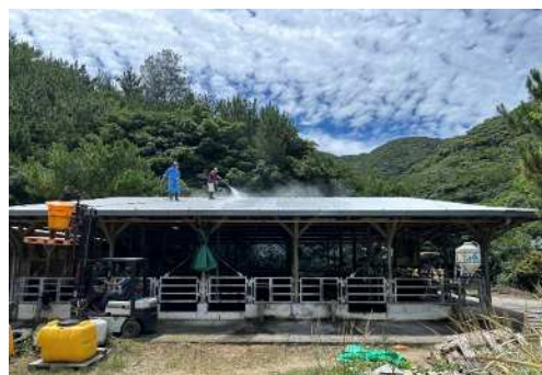
肉用牛における暑熱対策研修会 畜舎屋根への石灰塗布(7月掲載)
