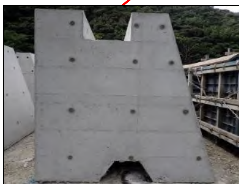
護岸ブロック
