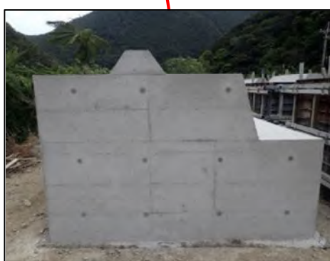
護岸ブロック
