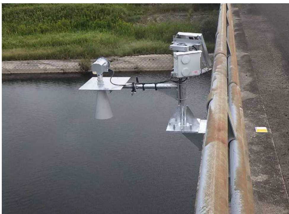
【危機管理型水位計（一級河川川内川水系羽月川）】
