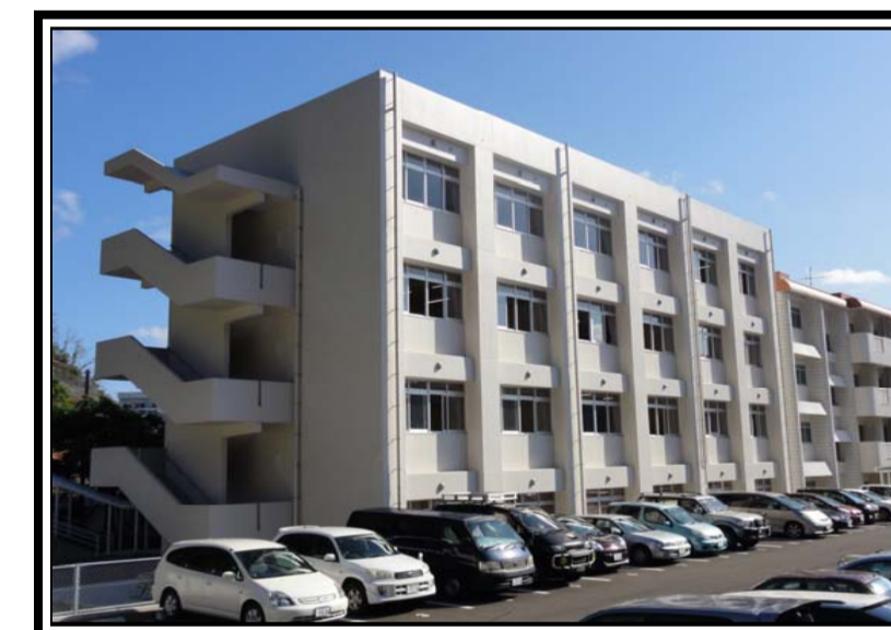
C棟 これで改築終了！ (H25完成)
