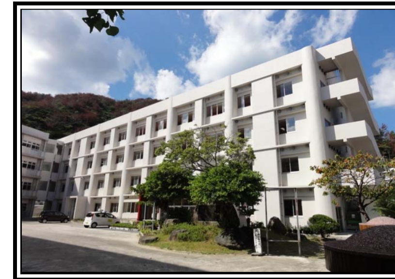
H23完成のA棟 一番大きな校舎です。
