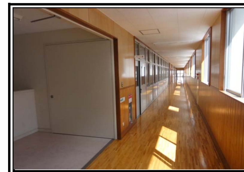
A棟内部廊下 端から端まで見渡せます。
