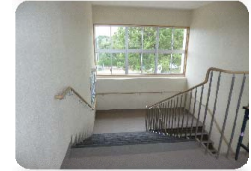
階段室 明るく開放的
