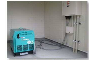
災害時に備え、自家発電機 を設置しました。
