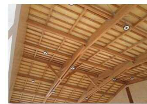
屋内運動場 照明はLEDになりました。
