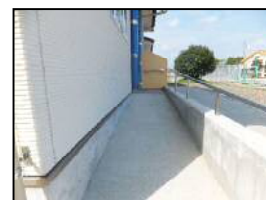
バリアフリー化されたスロープ
