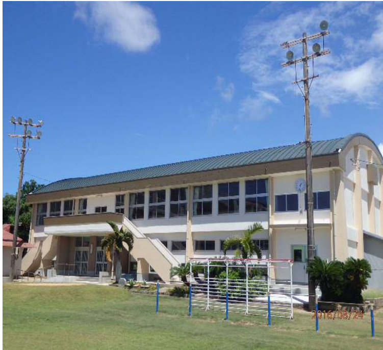
屋内運動場全景写真
