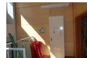
控室改修（配電盤）
