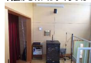
控室改修（放送室）
