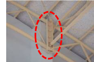
耐震補強（補強材を柱に固定）
