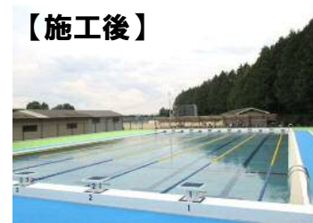
メンテナンス性を考慮した無塗装ステンレスへの改築
