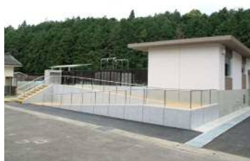
東側補助入口 見学者用スロープ設置
