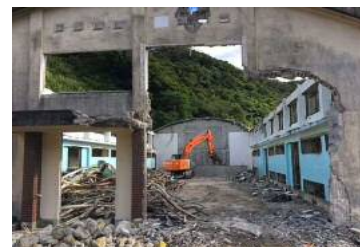
旧屋内運動場の 解体工事
