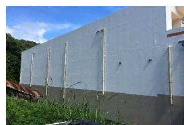
がけ崩れに備え、裏山側 に擁壁を設置しています
