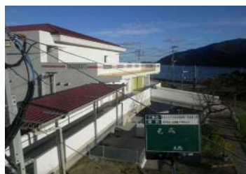
スロープを設置し バリアフリー化しました
