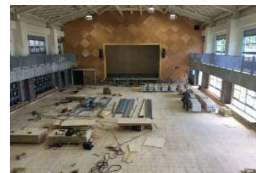
内部工事の様子
