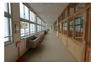
内壁・天井・床を 全面改修しました
